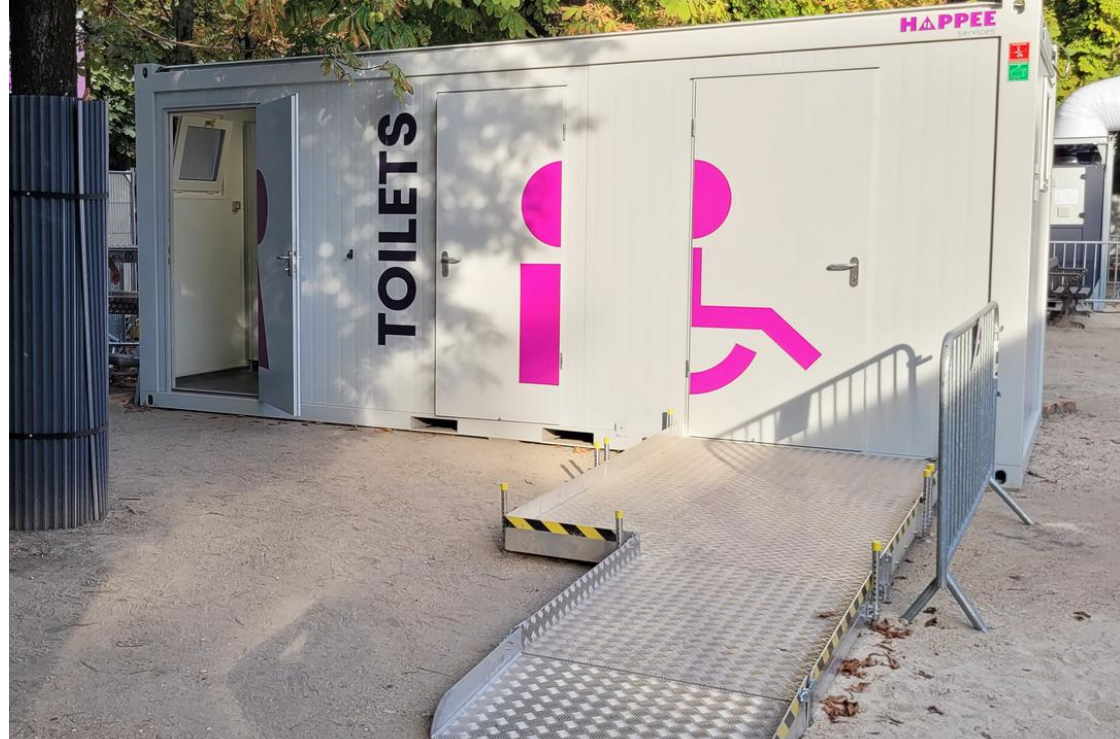
RAMPE D'ACCESSIBILITÉ PMR
